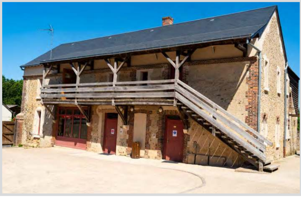
Le gîte, côté court
